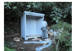
大型倉庫の設置
